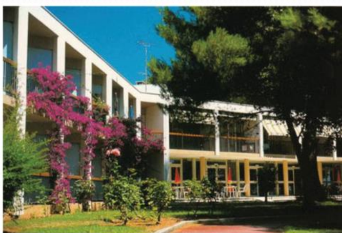
Photo du Bâtiment principal
